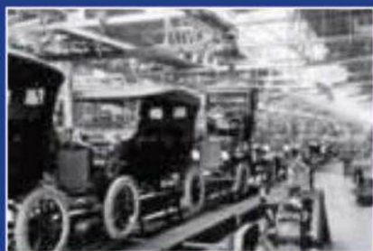
Ford Model T - výrobná linka
